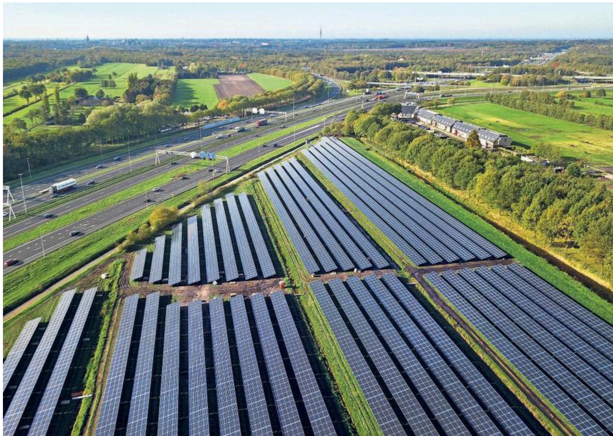
Het veld vol zonnepanelen langs de A1 bij knooppunt Eemnes. Vermoedelijk volgen er meer van dit soort velden.
